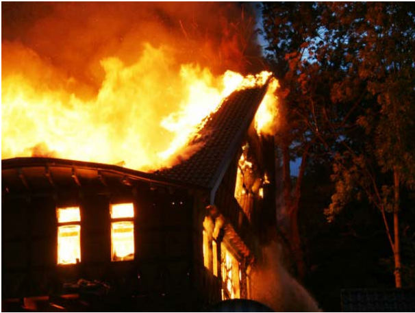
Abbildung 15: Einstürzende Giebelwand bei einem Dachstuhlbrand
